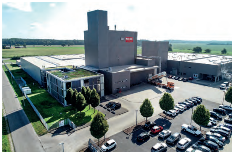
Einst platzte man im Ortsteil Wetten aus allen Nähten und sah sich zur Standort-Verlagerung an die Industriestraße von Wallfahrtsstadt Kevelaer verpflichtet. Heute scheint man dankbar für diesen Riesen-Schritt, den das Unternehmen machte.
